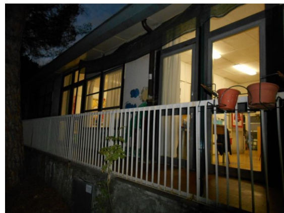
Figura 1.2 - Particolare della facciata retrostante
